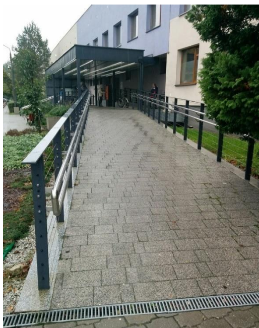
Zdjęcie nr 1. Zbyt długa i zbyt pochyła pochylnia prowadząca do wejścia do budynku GOK
